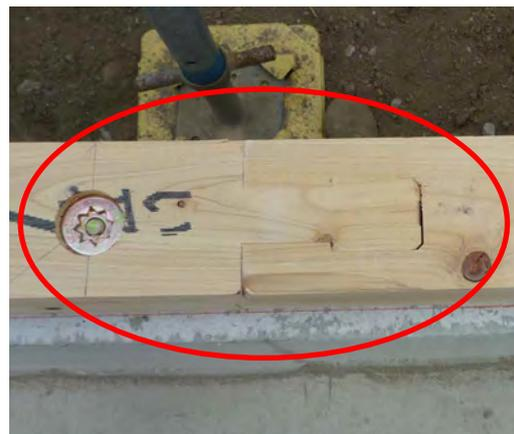
■ 検査項目:アンカーボルト「継手の設置状況」で不適合となる施工状況
