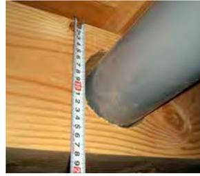
設備管を通すための大きな穴あけは横架材の欠き込み（断面欠損）扱いとなります
