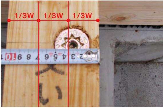
■ サポート冶具を使ったアンカーボルトの設置
