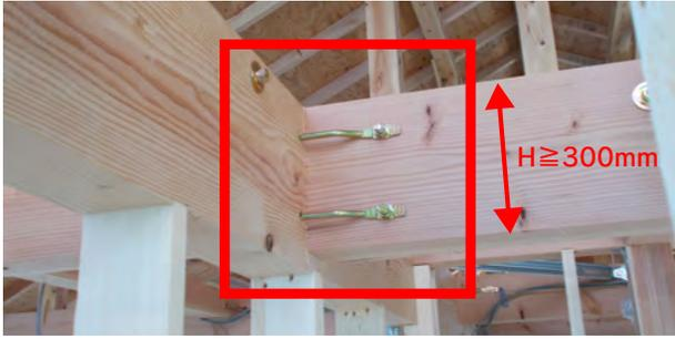
高さ300mm以上の横架材の接合金物は、上端または下端においてねじれが発生し、不具合が生じることもある
